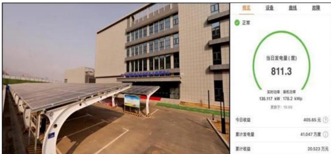
图 2 分布式光伏车棚及其发电量
