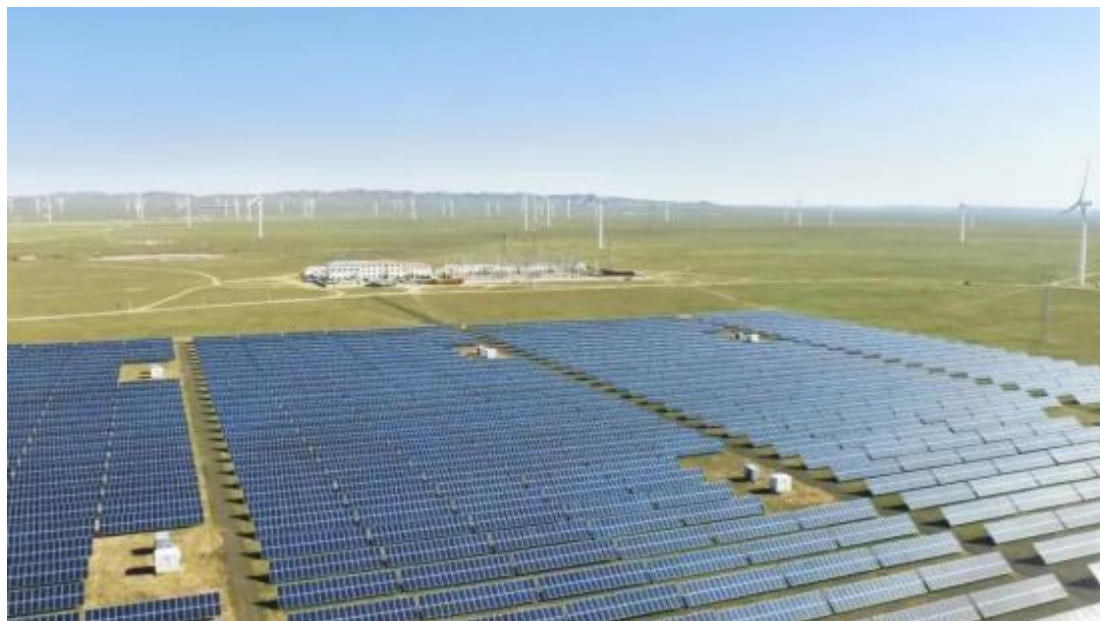
图 1 项目风光电厂实景图
